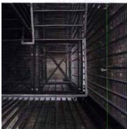
Vue d'un escalier greffé à l'extérieur.
