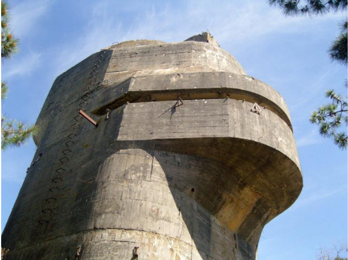
Tour de direction de tir de la batterie Karola, Ile de Ré, France, 1942-1944 @Philippe Prost
